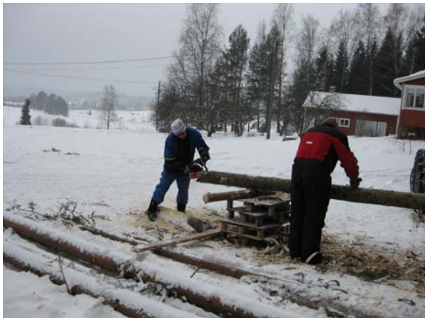
Tulevien peräkiinnitystolppien kuorintaa
